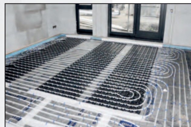
Verlegebeispiel vor der Estricheinbringung (Seniorenheim)
