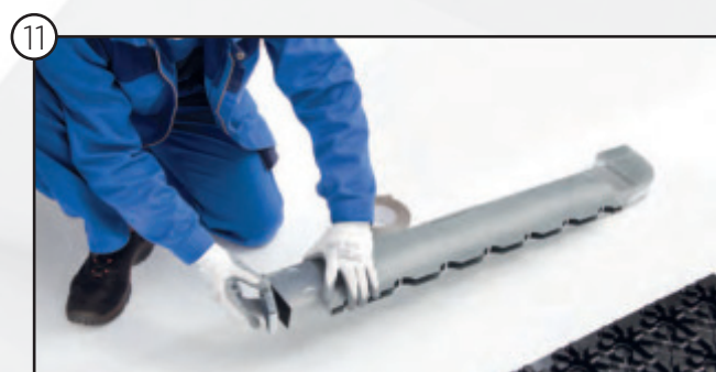
Verschließung der offenen Seite des Einblaskastens mit Deckel
