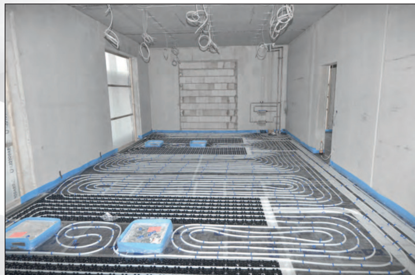
Verlegebeispiel vor der Estricheinbringung (Büro)
