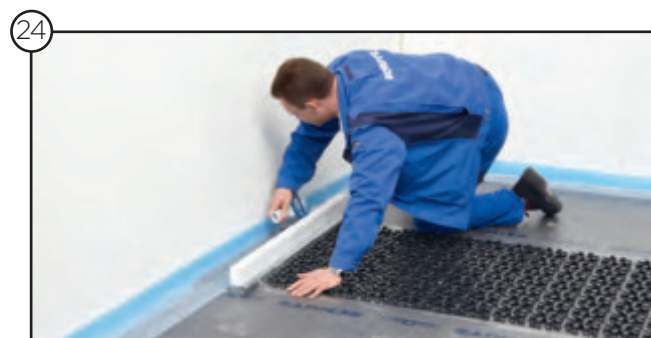
24 Vor der Estricheinbringung Rohbaumontageblock kontrollieren
