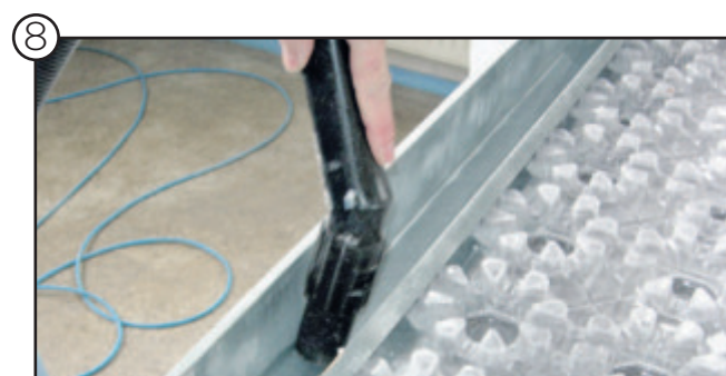
Reinigung des Luftauslasses mit einem Industriestaubsauger
