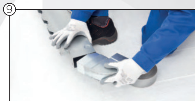
Montage Flachkanalbogen
