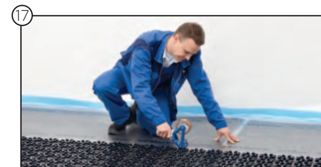
Abkleben der Stöße und Randdämmstreifen
