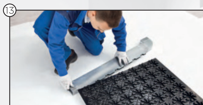
Montage des Einblaskastens am AIRCONOMY® Systemmodul
