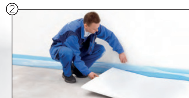
2 Trittschalldämmung auslegen
