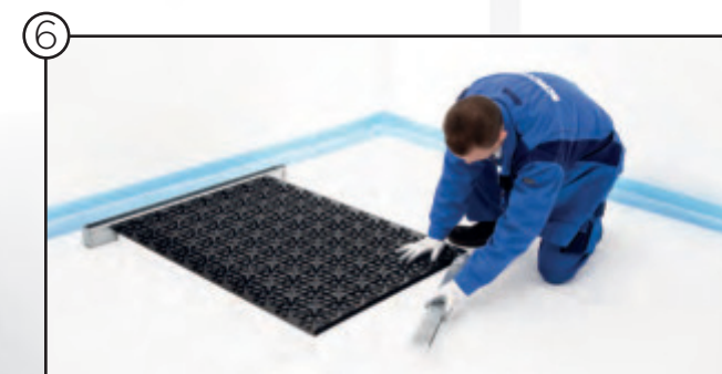
6 Verbindungselement montieren
