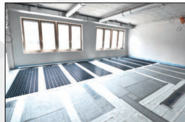
Bodenkonstruktion vor der Rohrverlegung
