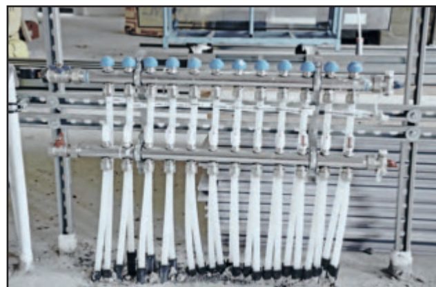
Heizkreisverteiler
