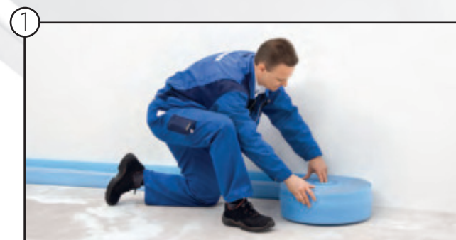
1 Randdämmstreifen montieren
