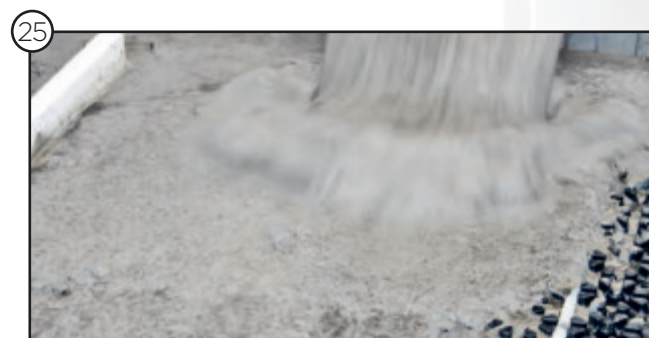
25 Einbringen des Estrichs
