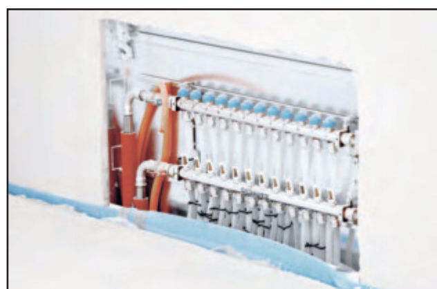
Heizkreisverteiler
