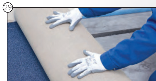
29 Verlegen des Bodenbelags
