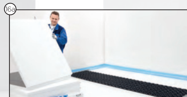
Auslegung der AIRCONOMY® Faltplatte
