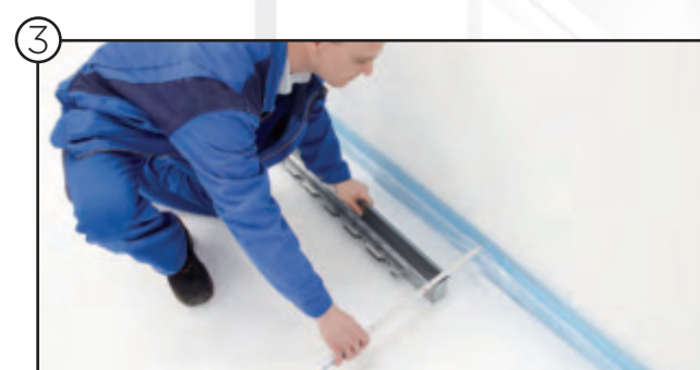
3 Ausblaskasten positionieren
