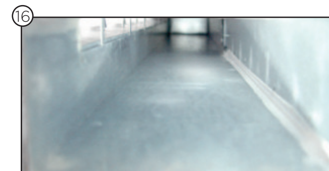
Kanalstrecke nach der Reinigung
