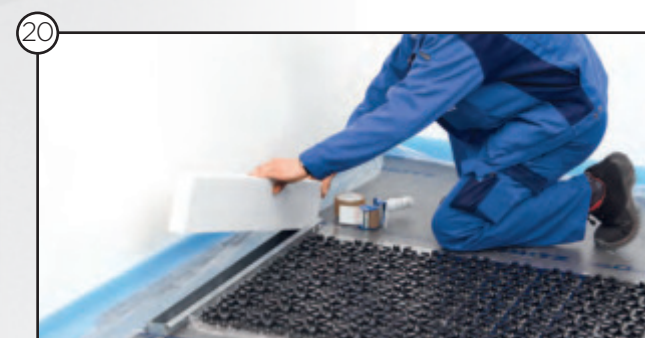
Einbau Rohbaumontageblock
