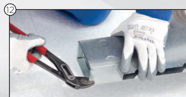
Sicherung Deckel durch Umlegung der Haltenasen
