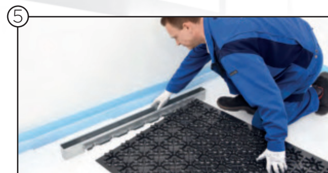
5 AIRCONOMY® Systemmodul in Ausblaskasten einschieben
