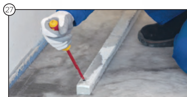
27 Entfernen des Rohbaumontageblocks
