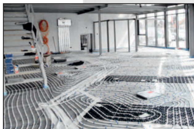
Verlegebeispiel vor der Estricheinbringung (Autohaus)
