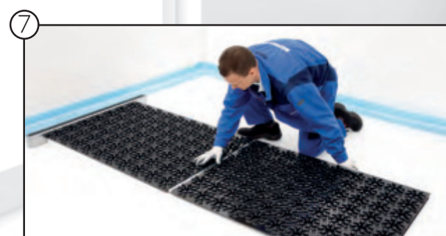
7 Zweites AIRCONOMY® Systemmodul montieren
