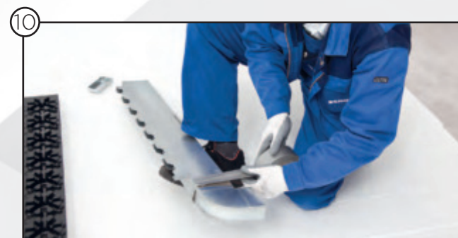
Abdichtung mit Bodenkanalklebeband (Gewebeeinlagen)
