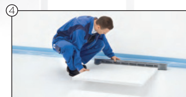
4 Distanzplatte zum AIRCONOMY® Systemmodul montieren
