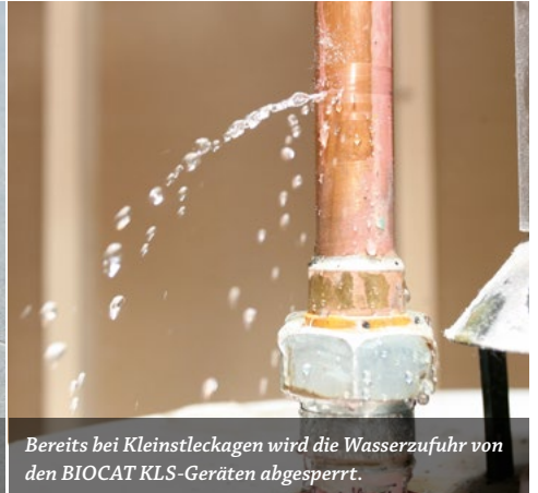
Unbemerkter Wasseraustritt gehört dank der Leckage-Sensoren der Vergangenheit an.
