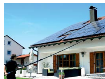
Reinigung Solarpanels
