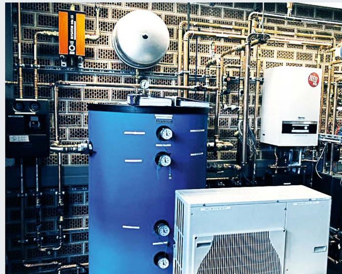
Geschlossene, fachgerecht installierte und sachgerecht betriebene Heizsysteme arbeiten durch Befüllung mit entsalztem Wasser und den Einsatz von Korrosionsschutzgeräten mit Schutzanodentechnologie, wie beispielsweise „SorbOx LI“ oder „trio.1“ von Elysator, dauerhaft und zuverlässig - ganz im Sinne der VDI 2035 (‘Vermeidung von Schäden in Warmwasser-Heizungsanlagen’).
